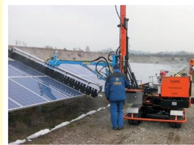
Cölöpöző működés közben
